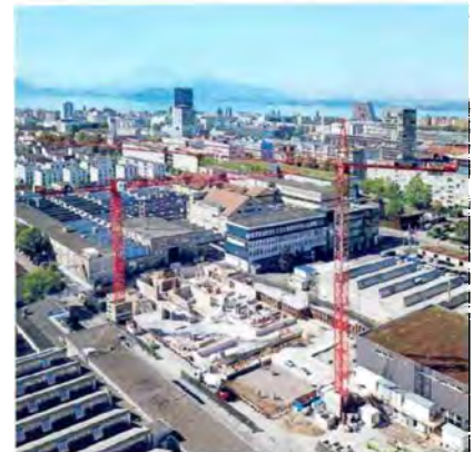
Für Zephyr Ost in Zug kam hochwertiger Recyclingbeton zum Einsatz.
